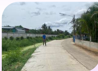
ก่อสร้างถนนคอนกรีตเสริมเหล็ก จากบ้านนางพุ่ม ชุมชน ถึงบ้านนายประเสริฐ หุนสรน้อย ชุมชนที่ 12 ชุมชนกอกอก-บ้านไร่สามัคคี
