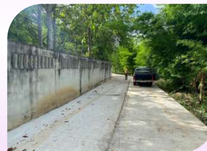
ก่อสร้างถนนคอนกรีตเสริมเหล็ก จากศูนย์ข้อมูลฐานทรัพยากรท้องถิ่นเทศบาล ถึงถนนทางหลวงชนบท 2421 ชุมชนที่ 12 ชุมชนกอกอก-บ้านไร่สามัคคี
