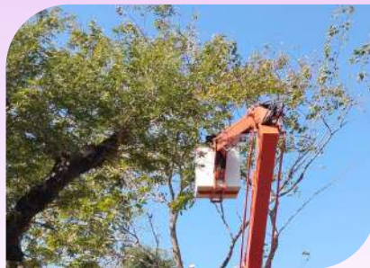
ตัดแต่งกิ่งไม้
