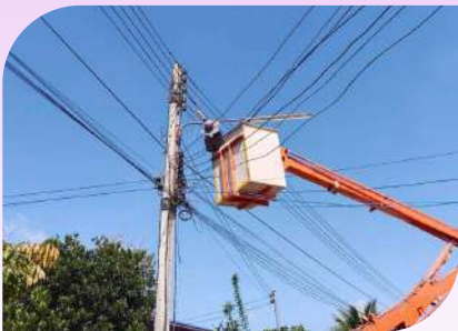
ซ่อมแซมไฟฟ้าส่องสว่าง
