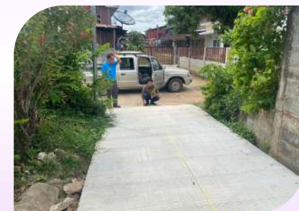
ก่อสร้างถนนคอนกรีตเสริมเหล็ก ซอยบ้านนางพูน สรน้อย ชุมชนที่ 1 ชุมชนบ้านบุโกรก
