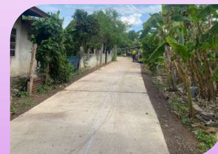
ก่อสร้างถนนคอนกรีตเสริมเหล็ก จากบ้านนางประทุมทิพย์ พรเกษม ถึงบ้านนายแฉล้ม ชาติครบุรี ชุมชนที่ 5 ชุมชนสรน้อยร่วมใจพัฒนา
