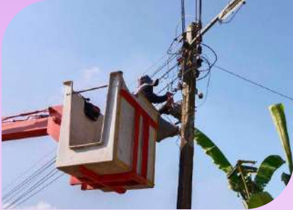
ซ่อมแซมเสียงตามสาย
