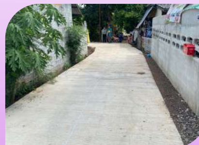
ก่อสร้างถนนคอนกรีตเสริมเหล็ก จากบ้านนางประจวบ พลบัตร ถึงบ้านนายวิฑูร สวรรค์ดอน ชุมชนที่ 9 ชุมชนทุ่งจามรุ่งเรือง
