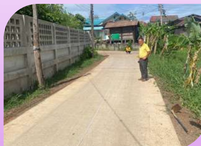
ก่อสร้างถนนคอนกรีตเสริมเหล็ก จากบ้านนายพร้อม ดำริห์สรน้อย ถึงบ้านนายอู๊ด ชมดอน ชุมชนที่ 6 ชุมชนบ้านสรน้อย
