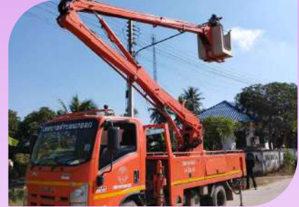
ซ่อมแซมไฟฟ้าส่องสว่าง
