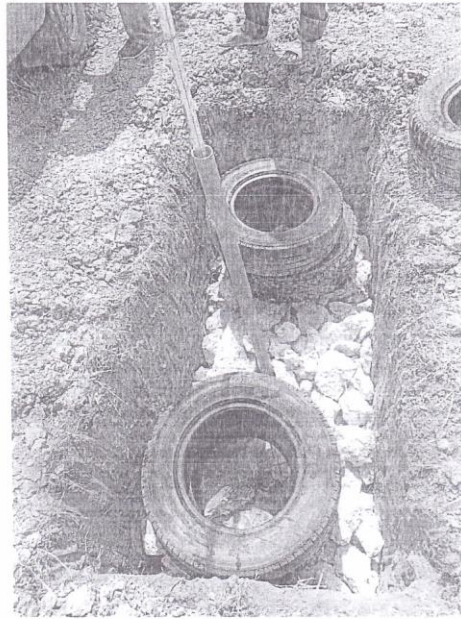
ภาพถ่ายการดำเนินงานธนาคารน้ำใต้ดินภายในบริเวณสำนักงานเทศบาลตำบลนกกอก จุดที่ ๕
