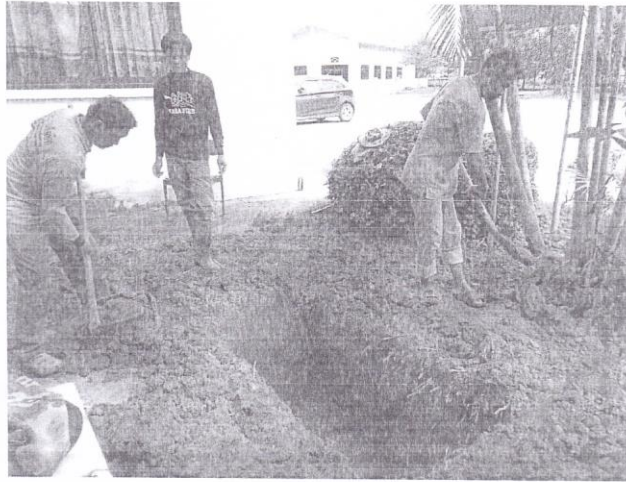
ภาพถ่ายการดำเนินงานธนาคารน้ำใต้ดินภายในบริเวณสำนักงานเทศบาลตำบลนกกอก จุดที่ ๒
