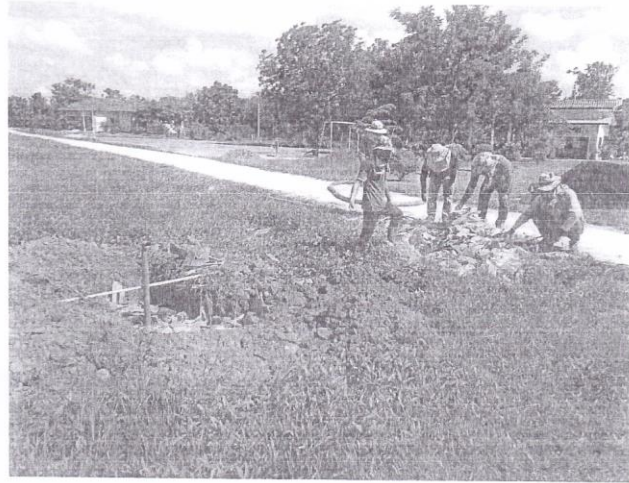
ภาพถ่ายการดำเนินงานธนาคารน้ำใต้ดินภายในบริเวณสำนักงานเทศบาลตำบลนกกอก จุดที่ ๓
